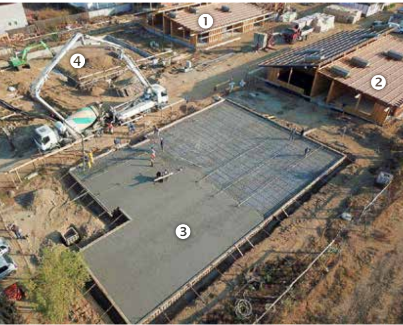
Stand Ende Oktober, zwei Blocks unter Dach.
